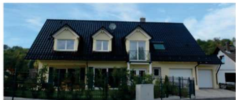
Dacheindeckung mit Tonziegel
