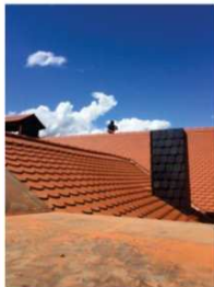
Tonnengaubeneindeckung
