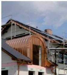
Tonnengaubeneindeckung
